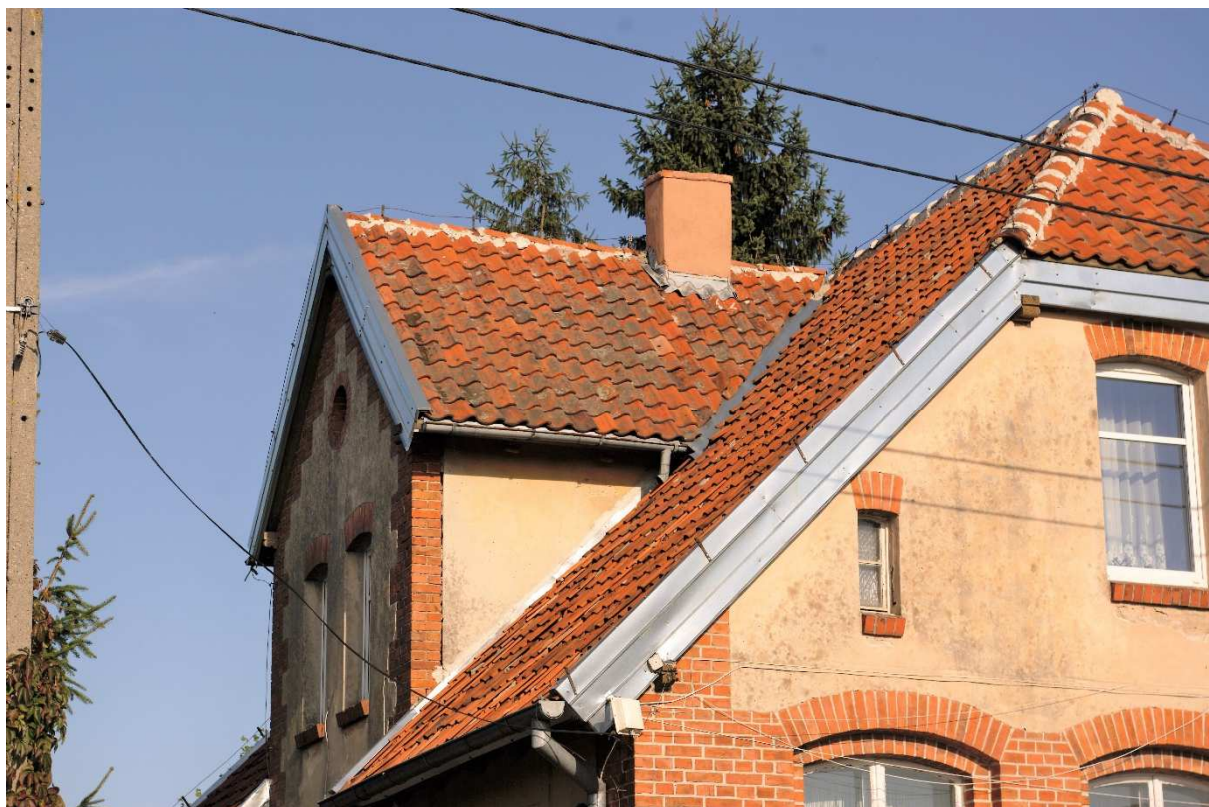
Widok części dachu od strony zachodniej
