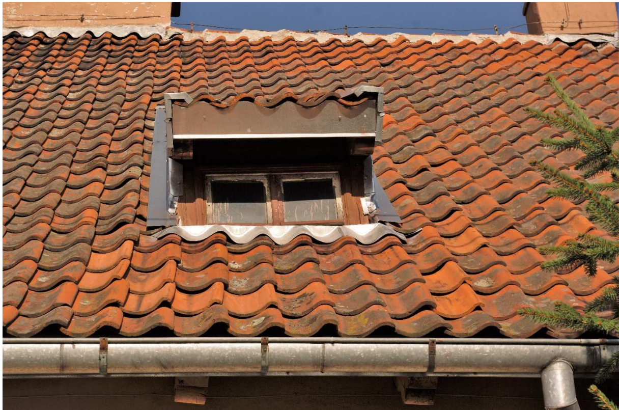
Widok lukarny na południowo - zachodniej połaci dachu – okno lukarny przewidziane do wymiany
