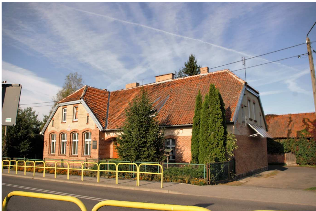
Widok budynku szkoły od strony południowej
