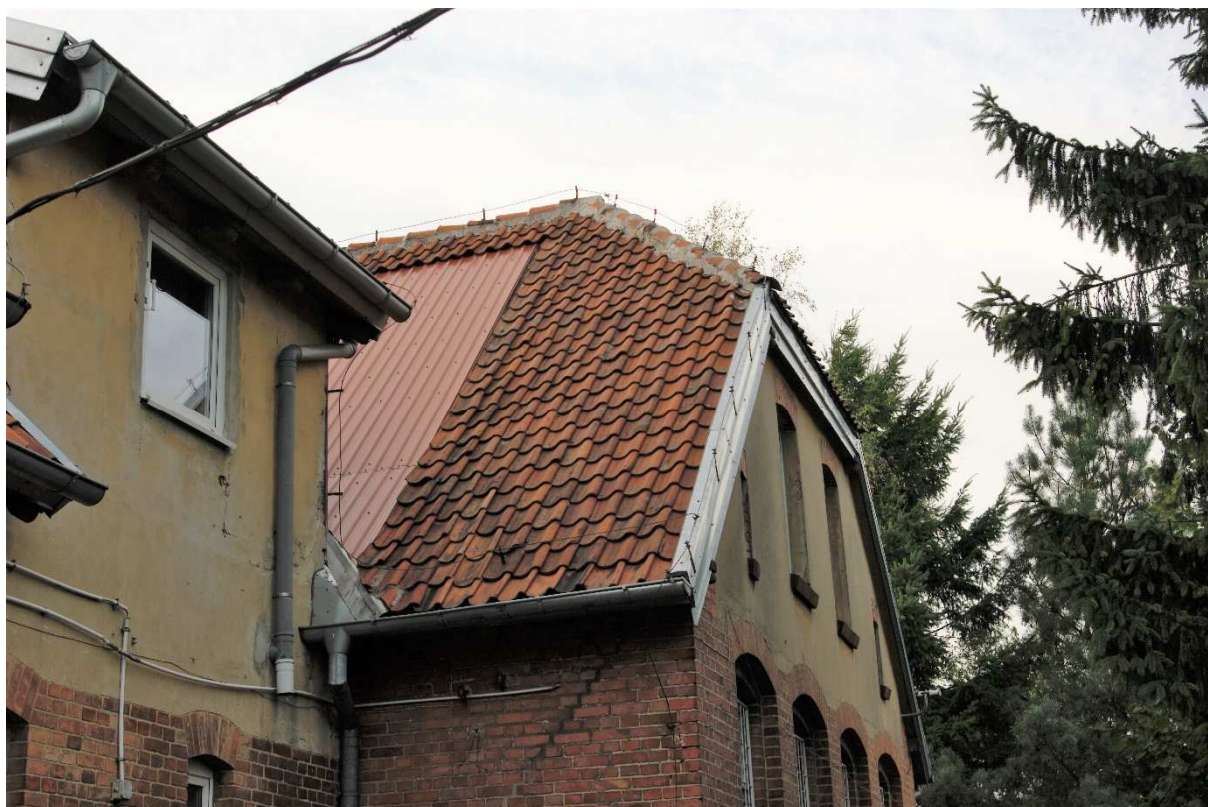
Widok części dachu od strony wschodniej – widoczne uzupełnienie z blachy trapezowej
