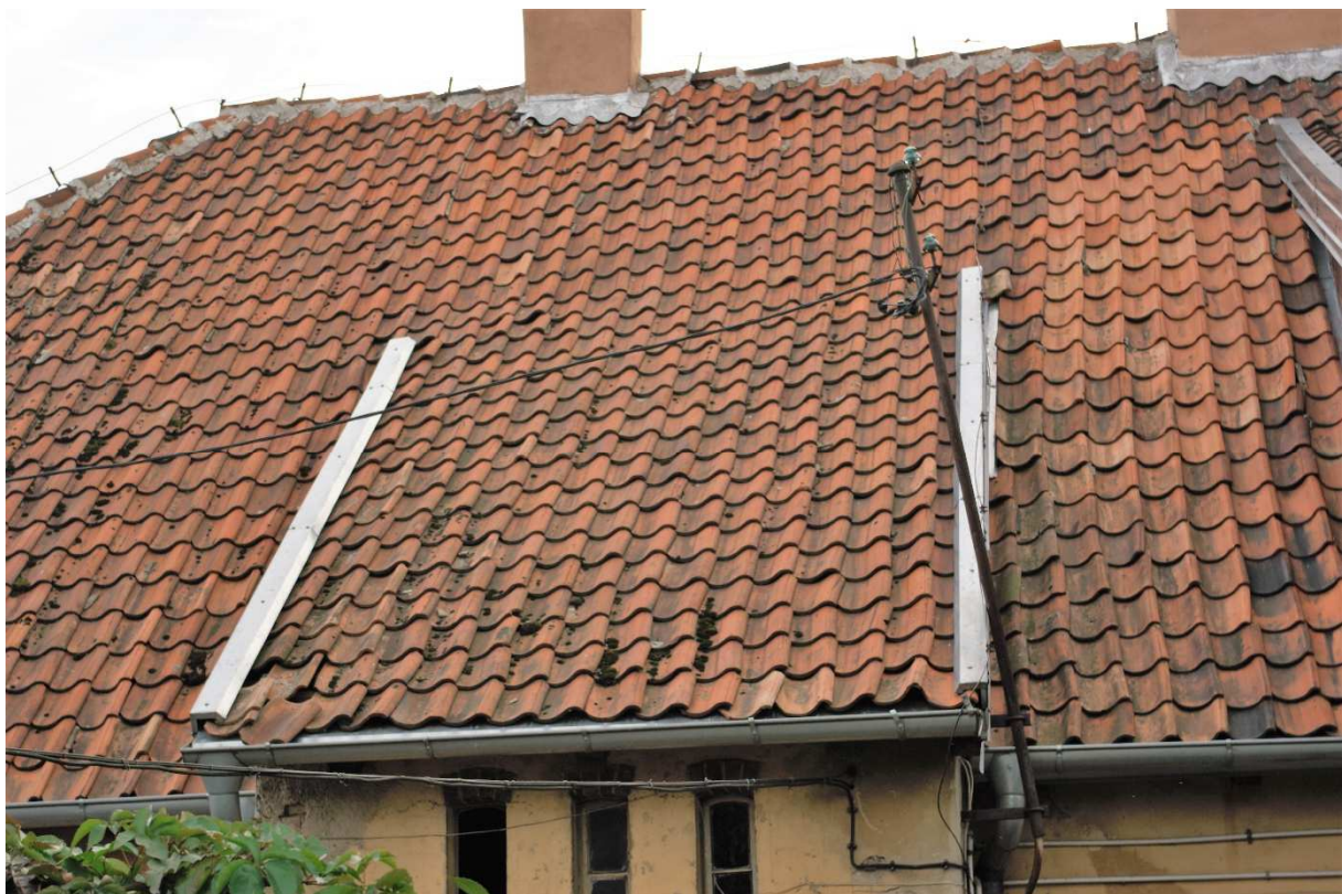
Widok części północno – wschodniej połaci dachu – widok masztu przyłącza energetycznego, który przewidziano do naprawy i wzmocnienia mocowania
