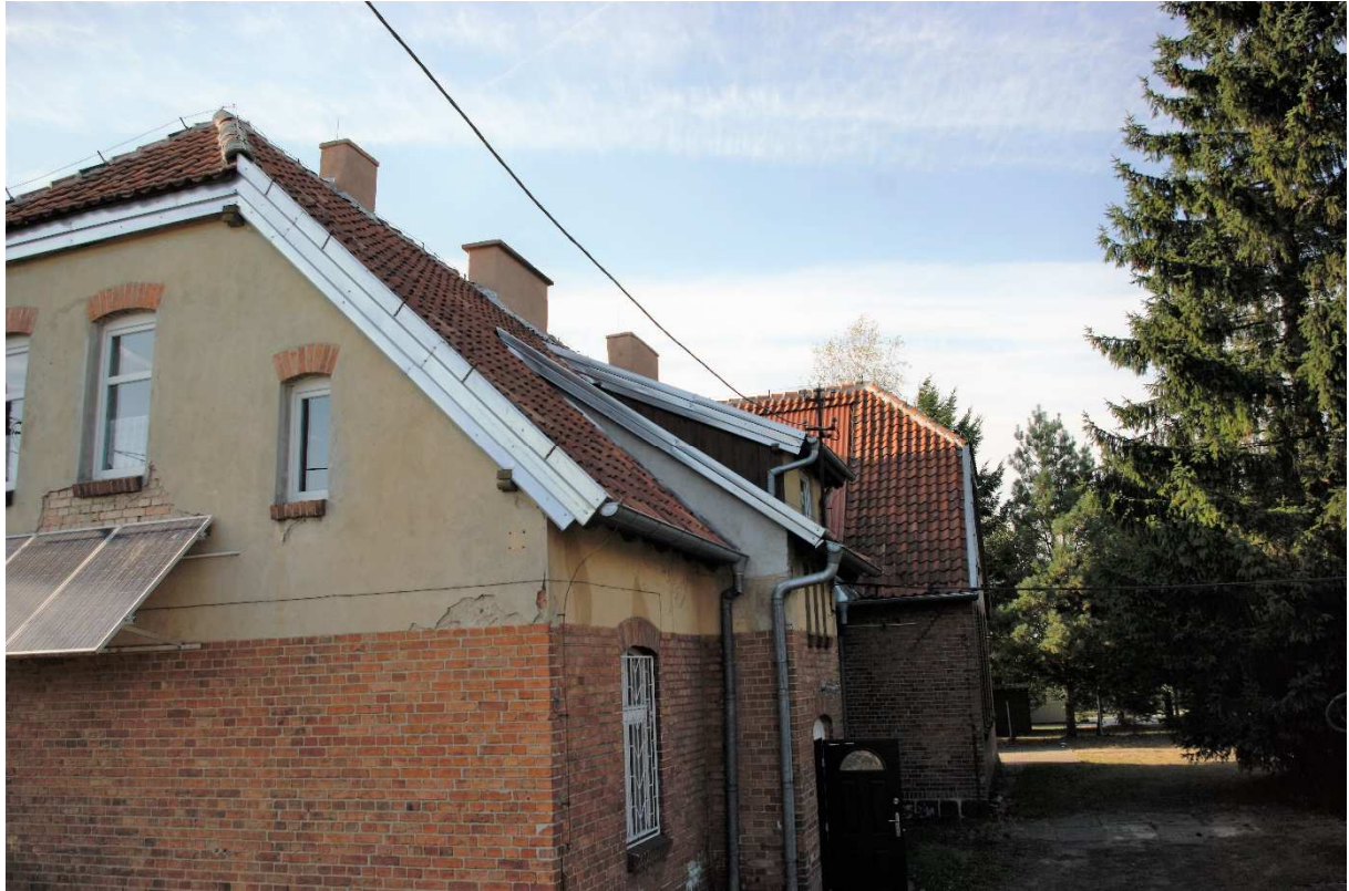
Widok budynku od strony wschodniej
