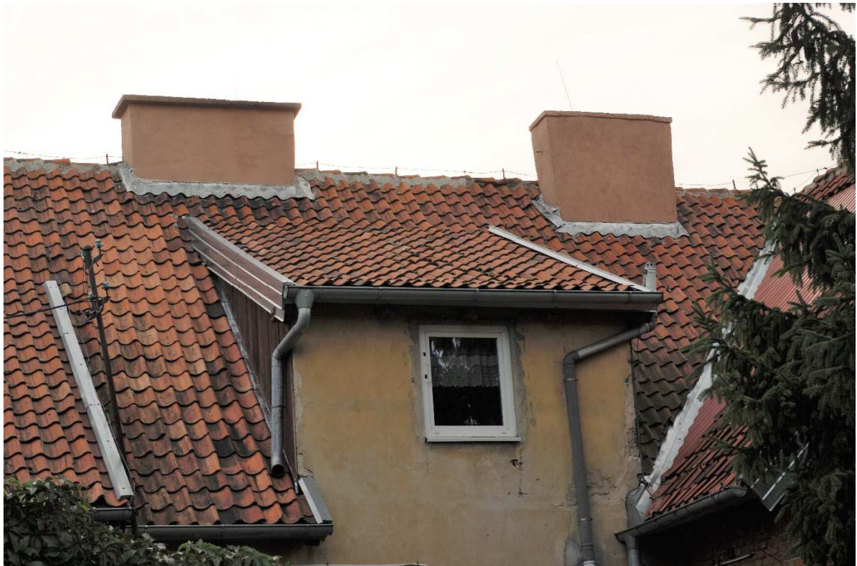
Widok części północno – wschodniej połaci dachu
