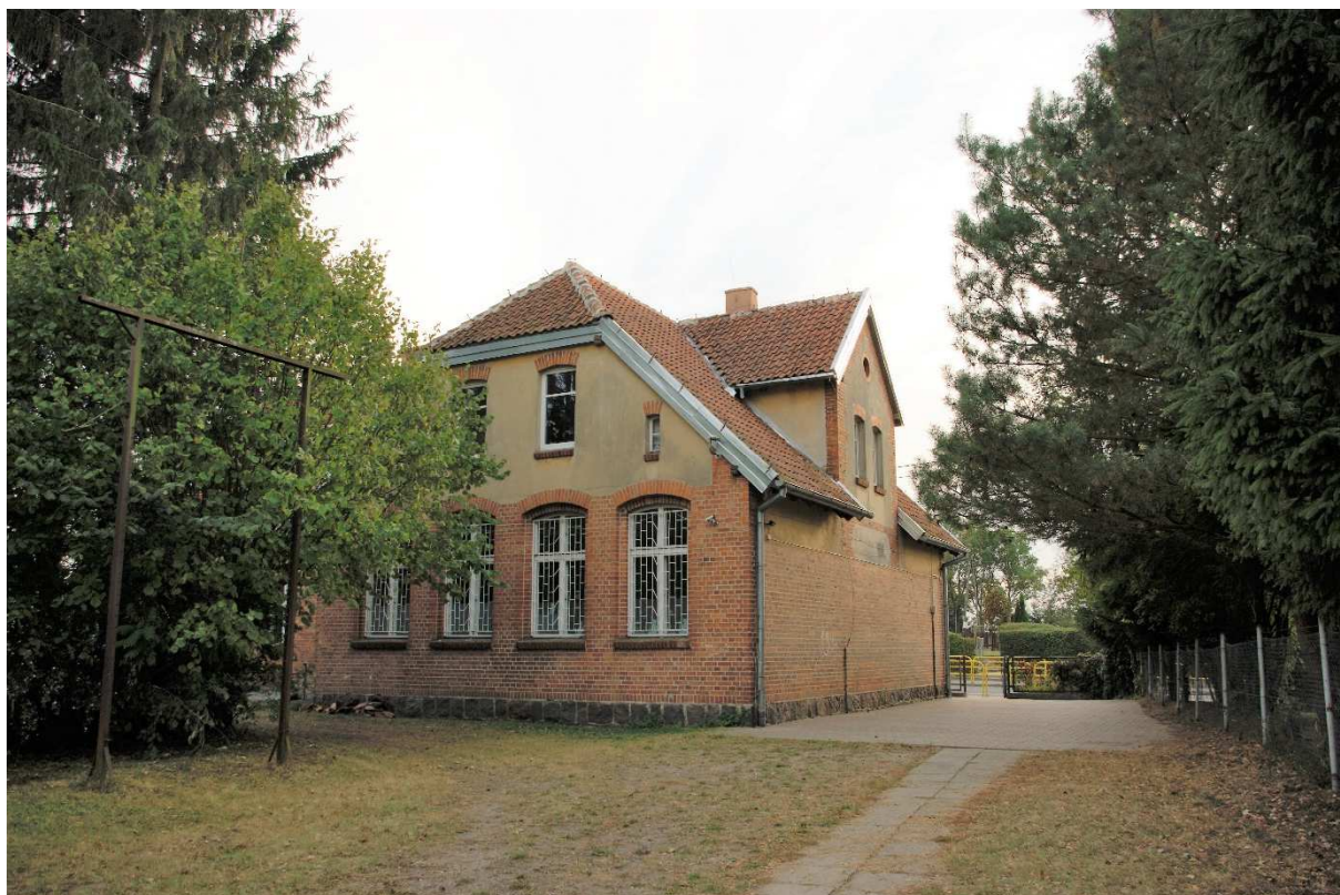
Widok budynku szkoły od strony północnej
